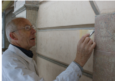
Paul Denfeld, hier im Mai 2009 bei der Untersuchung der zahlreichen früheren Farbaufträge an der Fassade des Formonterhofs.
