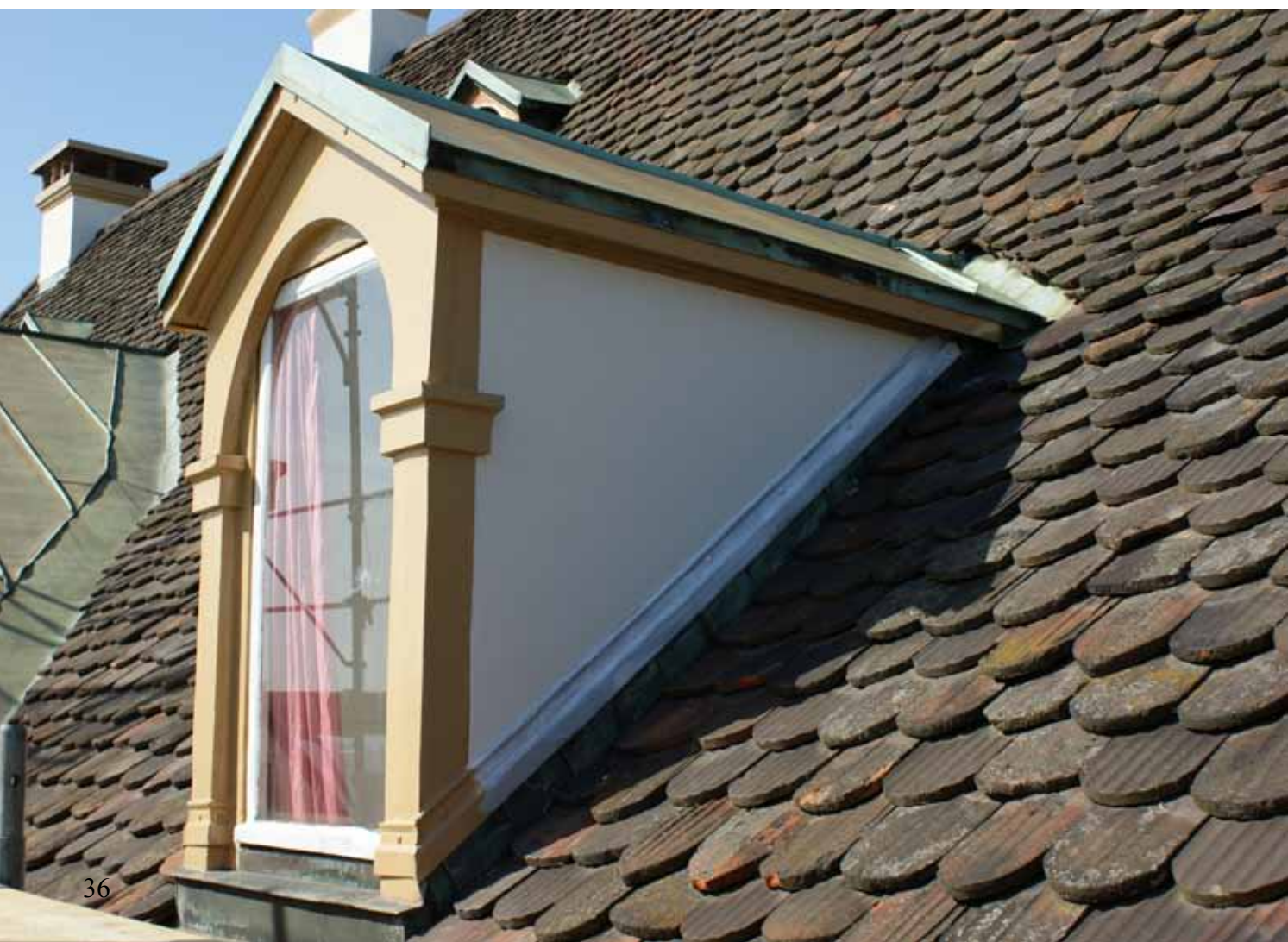
Lukarnen hofseitig in Blechkleid (oben) und auf der Strassenseite in Holz und gemauert.
