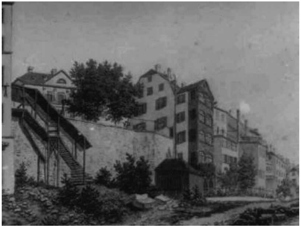
Diese Ansicht vom Rheinbord aus ist in der gleichen Zeit entstanden wie die beiden Darstellungen auf der vorangehenden Seite. Deutlich sichtbar ist der Fassadengiebel; er wurde 1832 von Melchior Berri aufgesetzt, nachdem er das Dach um rund 40 Centimeter angehoben hatte.
